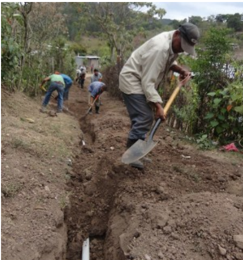
... und Verlegen einer Wasserleitung (Bilder: Cindy Sarmiento, asdenic)
