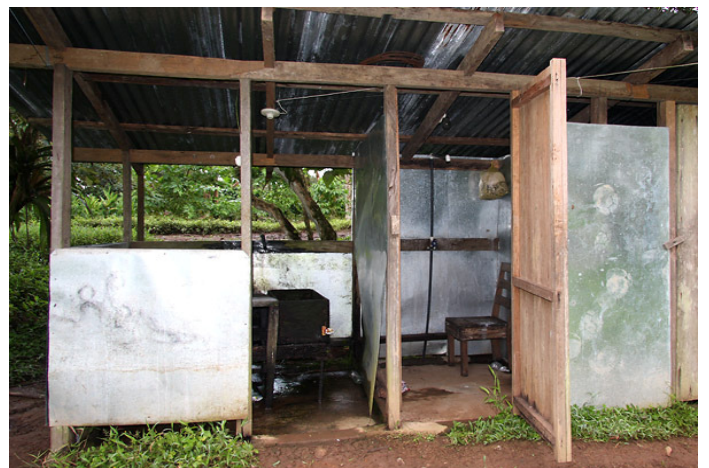
Links Waschstelle / Rechts Dusche
