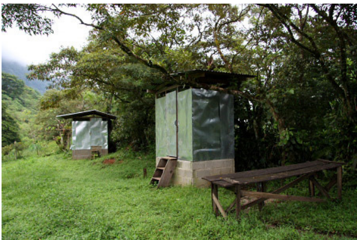
WC Anlagen (Latrine)
